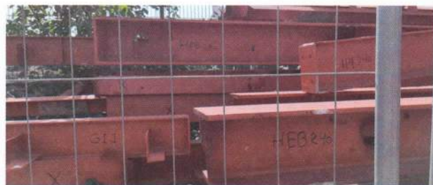
Boven: profielen uit donorgebouwen worden hergebruikt voor de sportaccommodatie (foto: Imd Raadgevende Ingenieurs).
